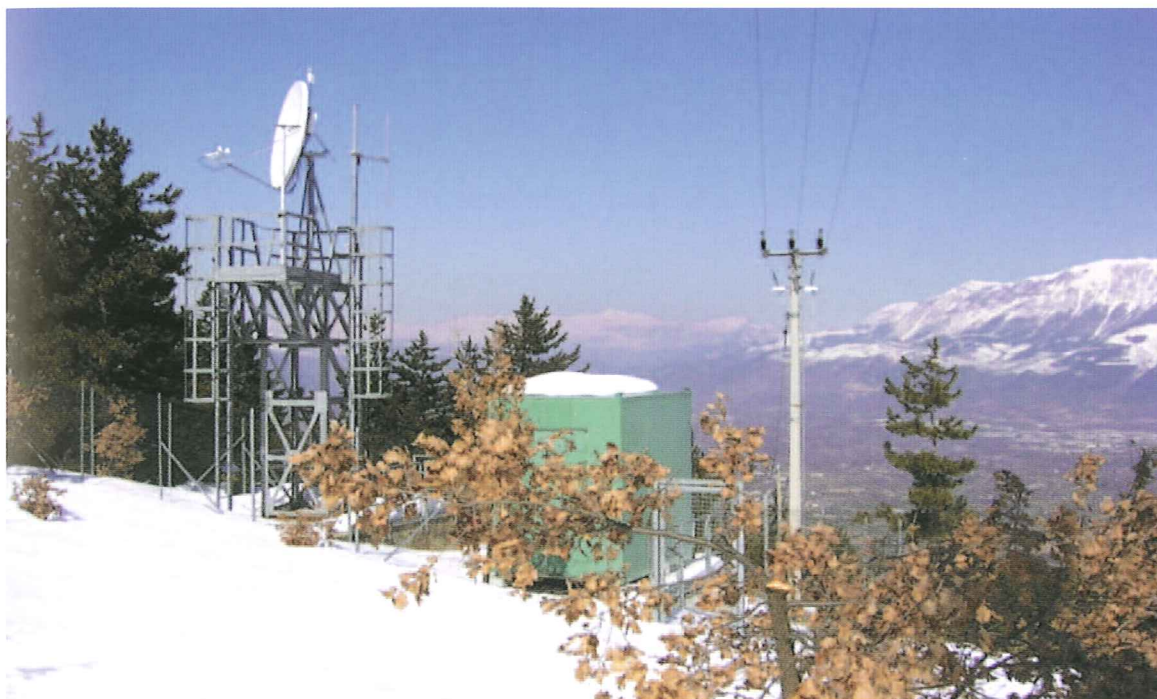
Fig. 7 Stazione sismica con trasmissione satellitare della rete sismica nazionale dell'INGV presente nella Conca Peligna, in particolare nelle vicinanze di Introdacqua.
