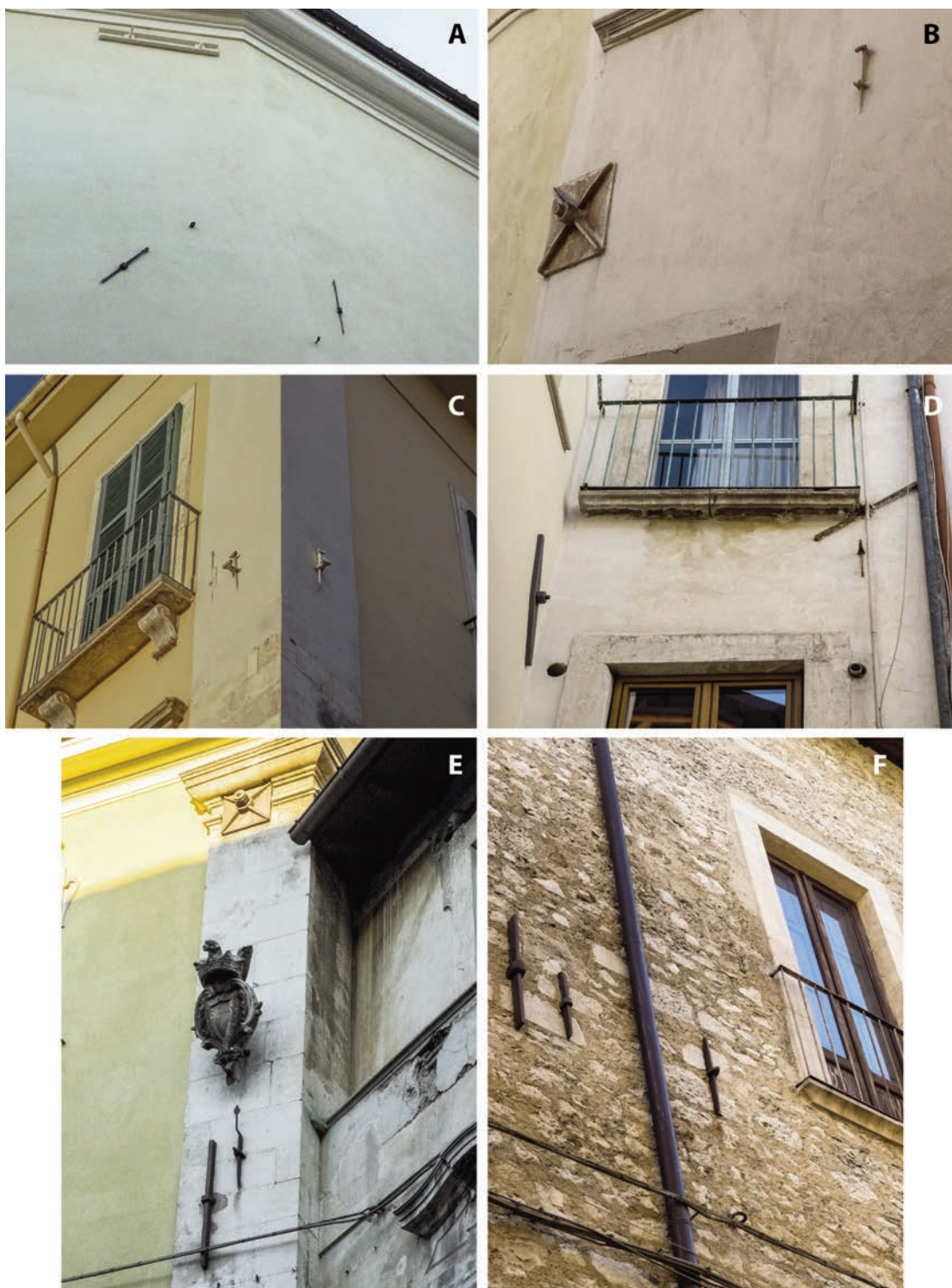
Figura 22 Interventi strutturali di epoche diverse negli edifici del centro storico (vedi figura 1 per l'ubicazione): A) emergenze di tiranti applicati nel corso del Novecento in largo Mazara; B) emergenza di tiranti, novecentesco (sinistra) e pre-novecentesco (destra) in via Corfinio; C) emergenze di un tirante novecentesco (sinistra) e di due tiranti pre-novecenteschi (destra) in via Manlio D'Eramo; D) emergenza di tiranti in edifici di via Papa Innocenzo VII: sulla destra, in alto, intervento strutturale novecentesco; in basso, intervento strutturale forse pre-novecentesco; sulla sinistra, si può notare l'emergenza di un tirante applicato dopo il terremoto del 2009; E) evidenze di interventi strutturali novecenteschi (in alto e in basso) e di un intervento pre-novecentesco in largo Palizze; F) interventi strutturali novecenteschi in vico dell'Ospedale, sul fianco settentrionale del complesso della S.S. Annunziata.
